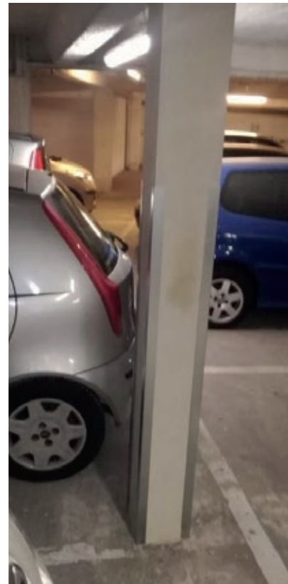
Stahlstütze mit Kantenschutzprofil
