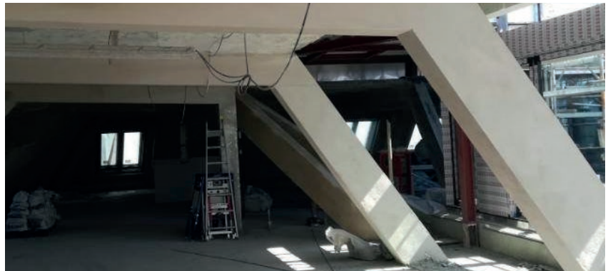
Stahltragwerke als Designelement
