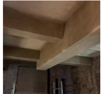
Kastenförmige Bekleidung von Deckenträgern
