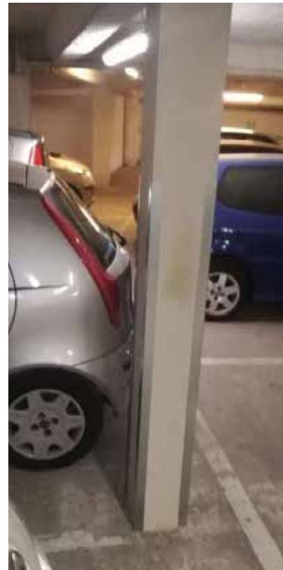
Stahlstütze mit Kantenschutzprofil
